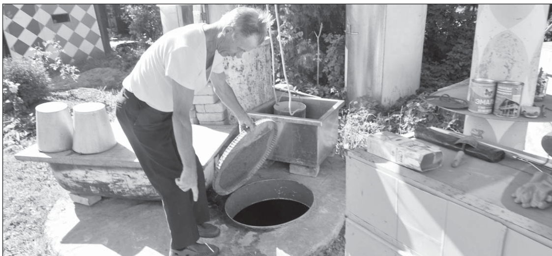
Это бетонное овощехранилище уходит вглубь почти на четыре метра!
