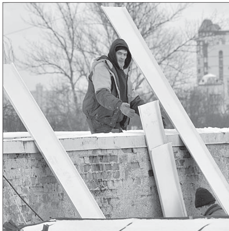
На питерских крышах зачастую экономят: покрывают самым дешевым, но не самым долговечным материалом - оцинкованной сталью
