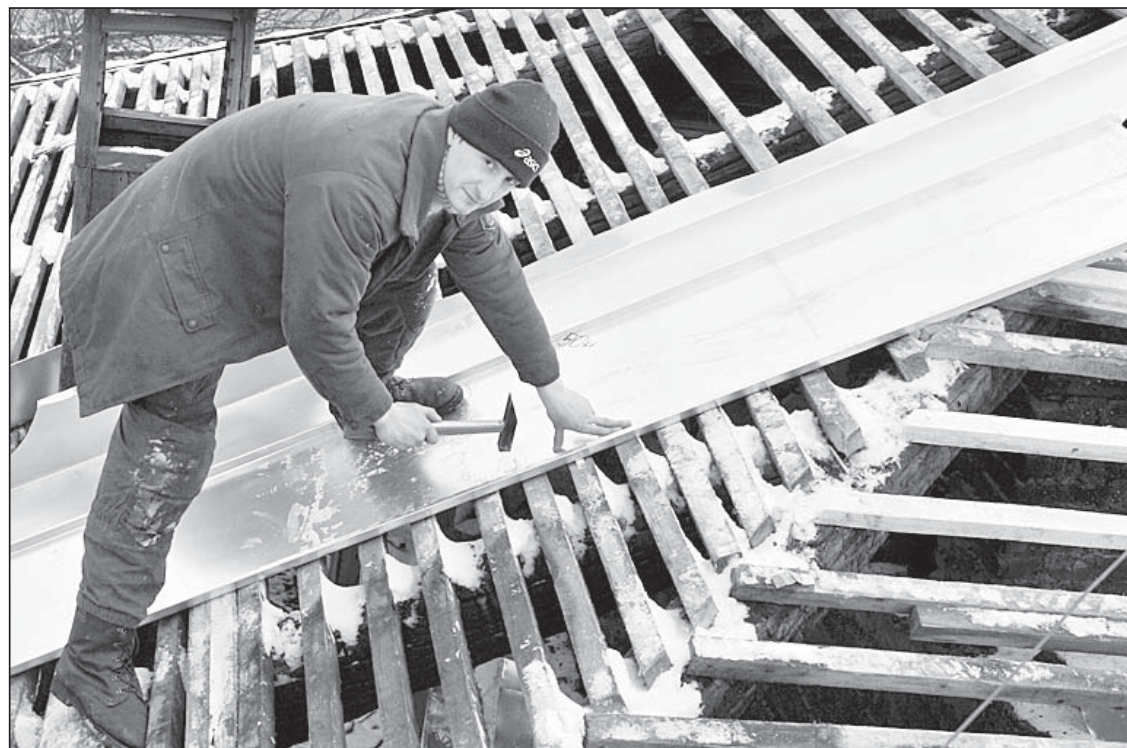
Многие думают, что крыши текут из-за дырок, появляющихся на цинковых пластинах, - на самом деле трещины возникают на стыке двух соседних пластин. Квалифицированный кровельщик никогда не допустит, чтобы подобное произошло
