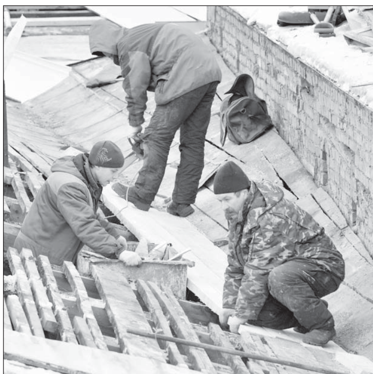
На крыше полно работы: пригождаются навыки плотника, жестянщика, маляра
