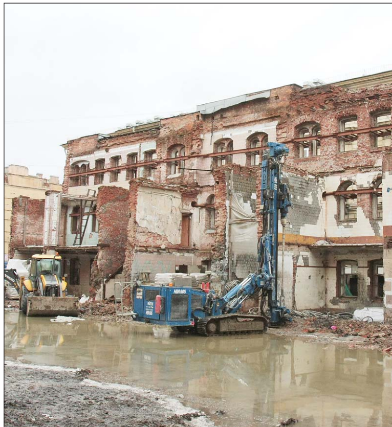
На месте Пушкарских бань развернулась стройка
