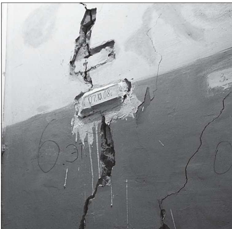
Если маячок треснул, нужно останавливать соседнюю стройку
