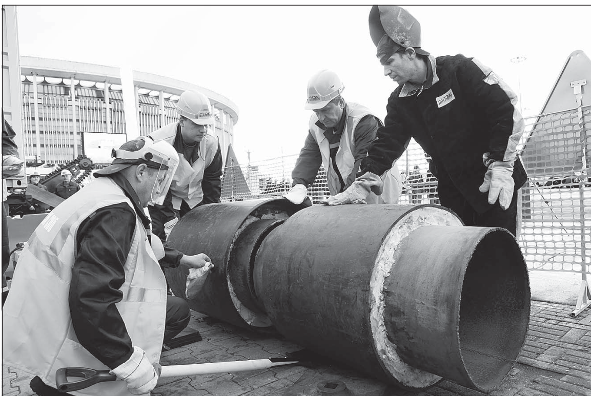
Образцово-показательная сварка трубы теплоснабжения
