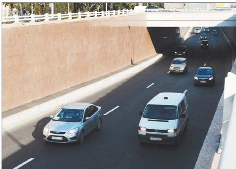
Водители не могут нарадоваться на новый тоннель
