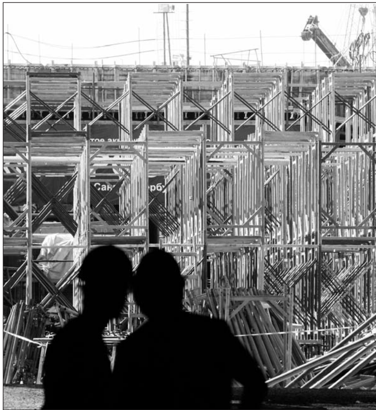
Работы еще много, поэтому строители трудятся без выходных
