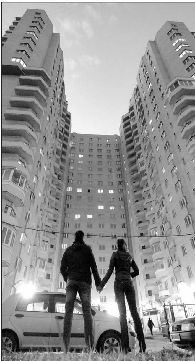
От таких новостроек лучше держаться подальше: ненароком можно куском облицовки получить по макушке
