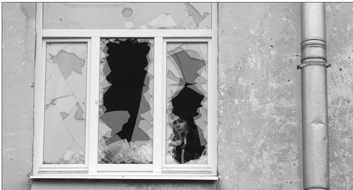
Струя кипятка пробил оконные стекла и затопила квартиры
