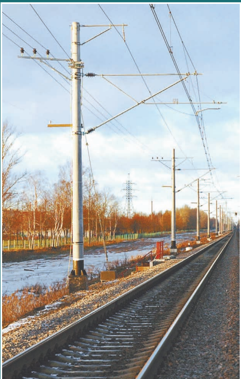
Контактная сеть КС-200-06 для скорости движения 200 км/ч на перегоне Саблино - Тосно Октябрьской железной дороги
