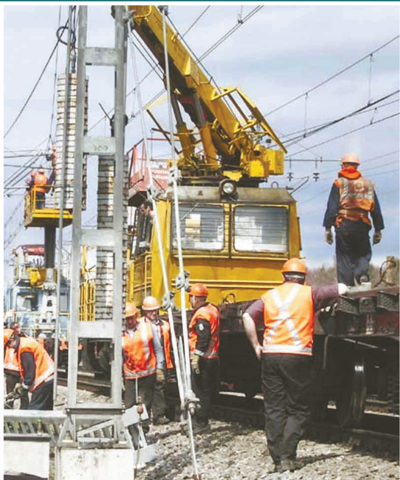
Монтаж опытных участков контактной сети для скорости движения 250 км/ч на участке Калашниково - Лихославль Октябрьской железной дороги
