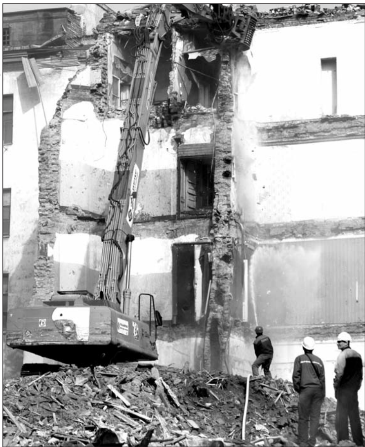
Вот так «бережно» демонтируют историческое здание на Малой Морской
