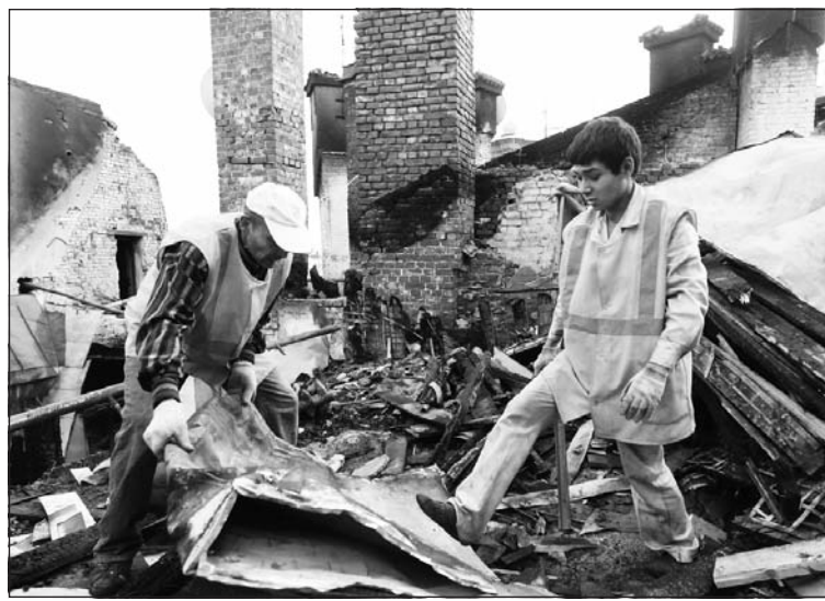
Гастарбайтеры не успели управиться с ремонтом здания, как фронт работ резко увеличился
